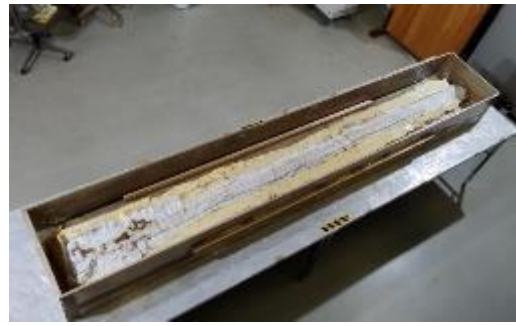
発泡ウレタン流し込み用木枠製作 (2024年8月23日)
